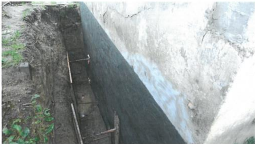
Zdj. 7. Izolacja zewnętrzna ściany wschodniej
