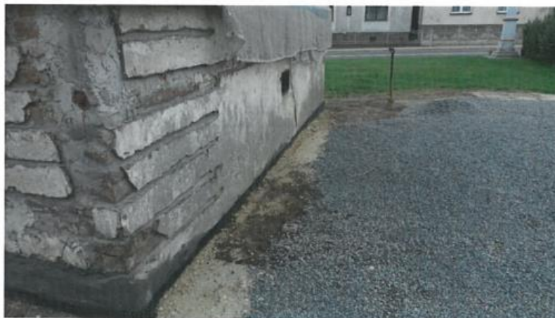
Zdj.16. Ściana zachodnia po wykonaniu hydroizolacji
