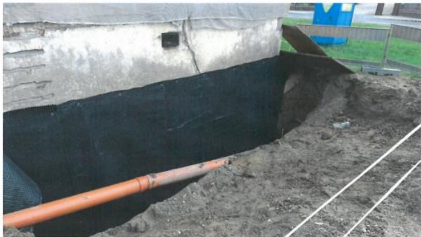
Zdj. 8. Folia dystansowa na ścianie zachodniej
