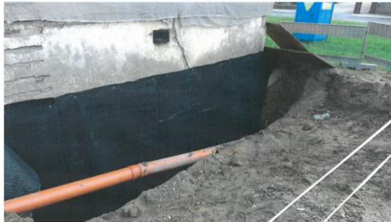
Zdj. 8. Folia dystansowa na ścianie zachodniej
