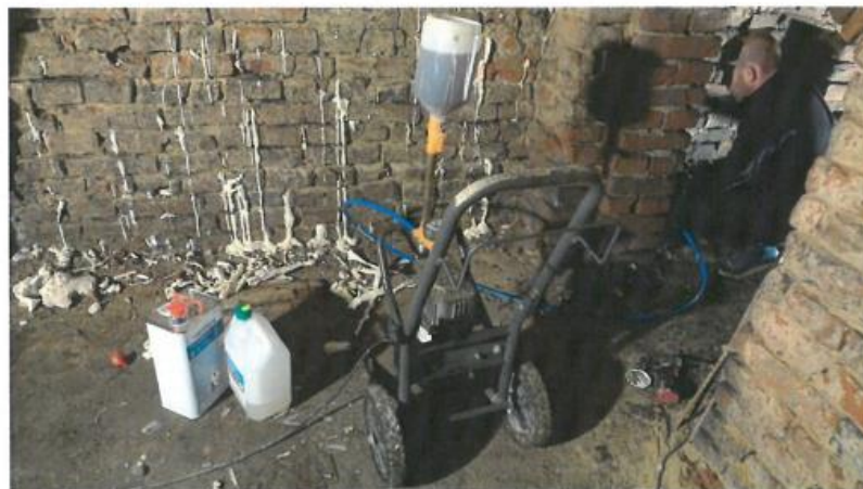
Zdj. 4. Iniekcja poliuretanowa - narożnik północno-wschodni
