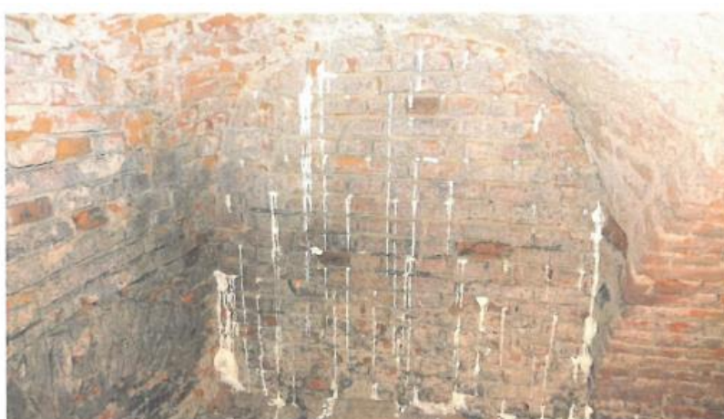
Zdj. 3. Iniekcja żywicami poliuretanowymi ściany północnej
