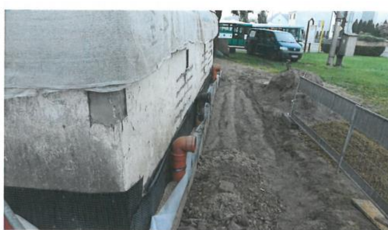
Zdj.15. Ściana południowa po wykonaniu tymczasowych wentylacji żetowych w miejscu istniejących okienek
