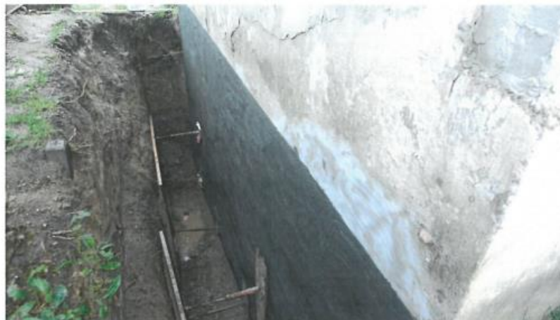
Zdj. 7. Izolacja zewnętrzna ściany wschodniej
