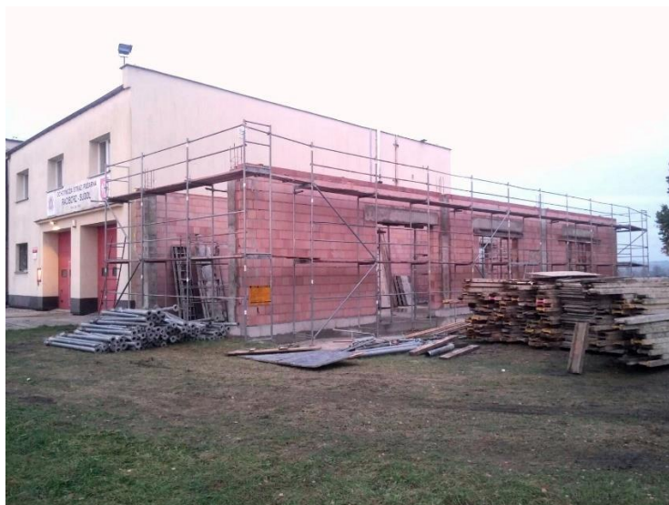
Obraz 5. Centrum ratownicze w trakcie budowy.
