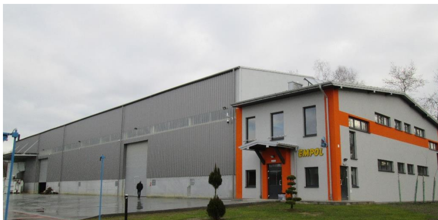
Obraz 4. Instalacja do mechaniczno - biologicznego przetwarzania odpadów.
